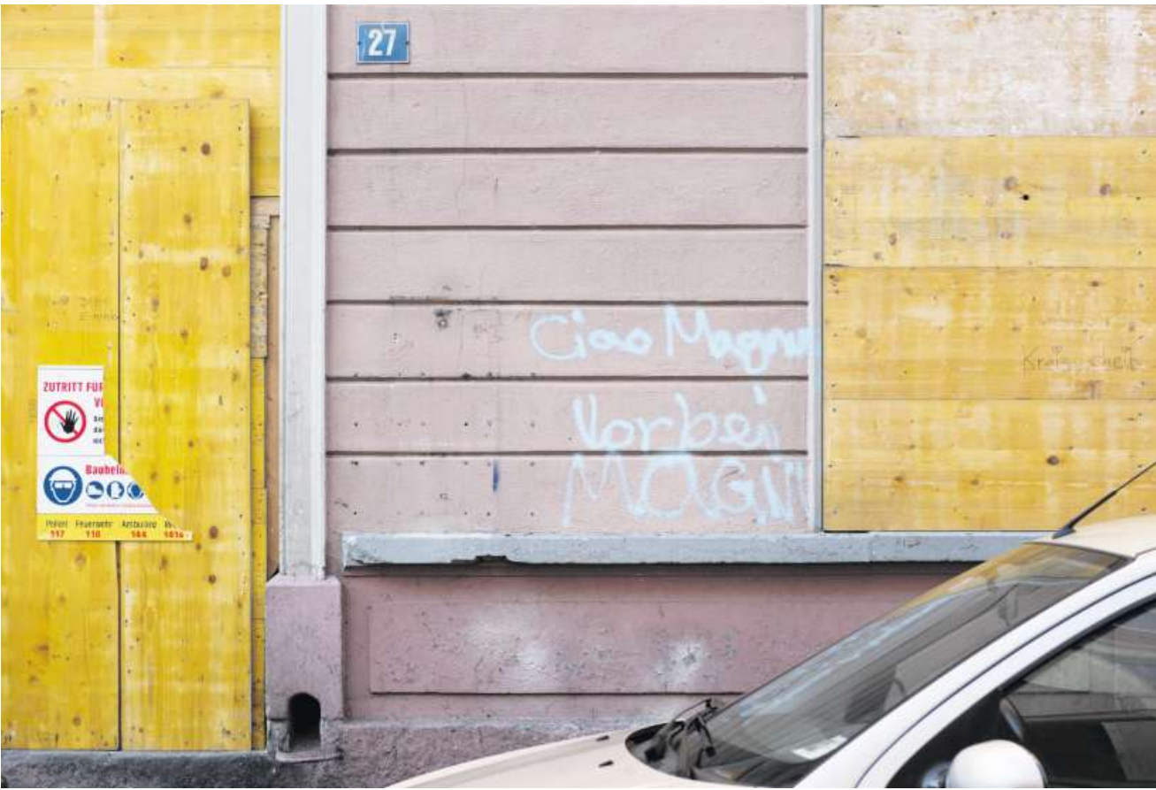
Die Liegenschaft an der Magnusstrasse 27 ist seit 2016 unbewohnbar.
